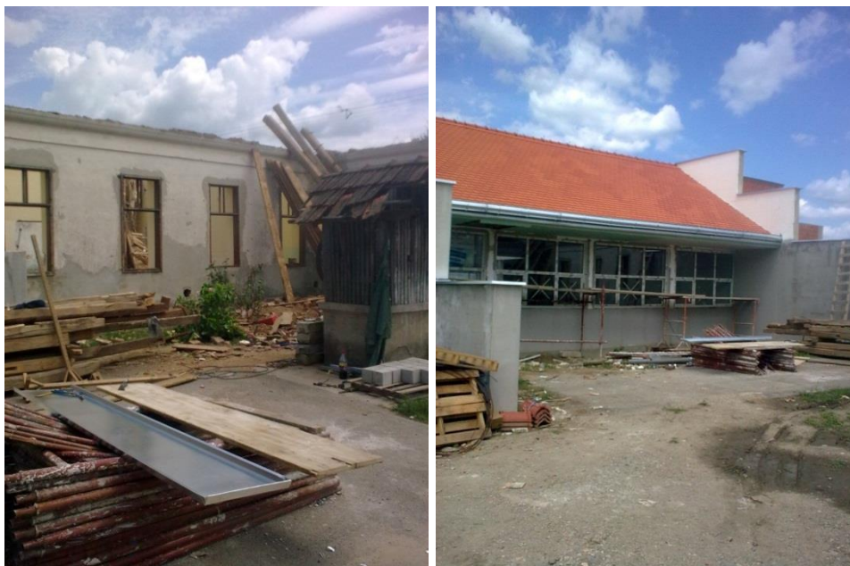
Rušenje stare i izgradnja nove školske zgrade u Velimirovcu
