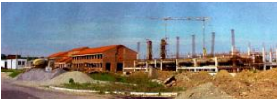
Dvorana u izgradnji, preuzeto iz „Građevinar“ 52,6 (2000.)
